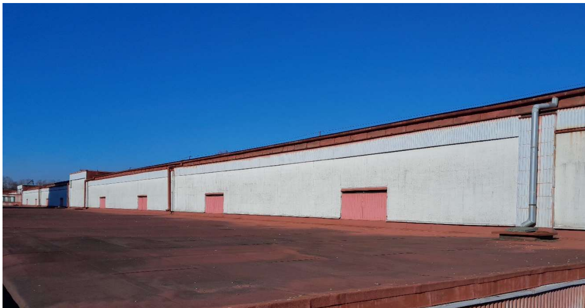
fot.1 Elewacja południowa (seg A i B).
