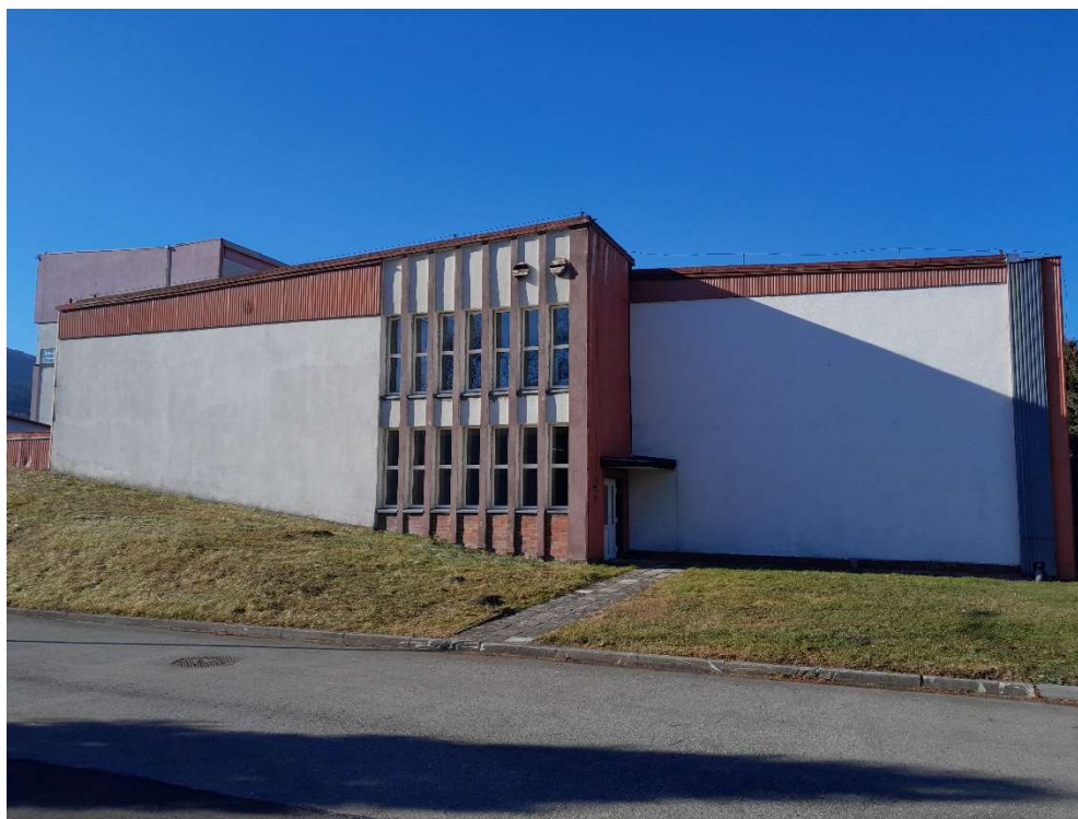
Fot.2 Elewacja wschodnia (seg.A)
