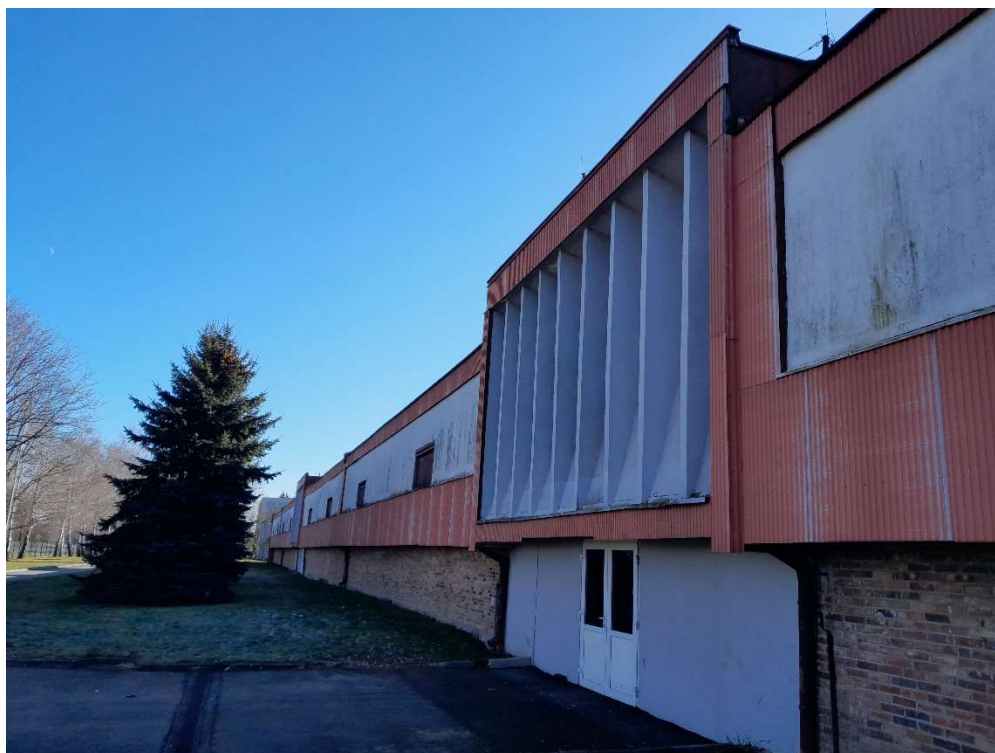
fot.3 Elewacja północna (seg. A i B).
